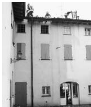
Il sopralluogo sul tetto
